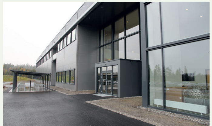
Hovedinngangen til bygget.
